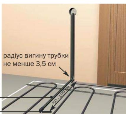
Вигини гофротрубки мають бути плавними, радіус вигину не менше 3,5 см.
